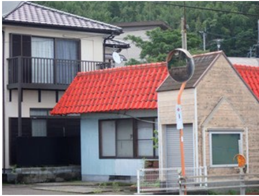
図 165 霧島市福山付近(降灰による汚れ)
