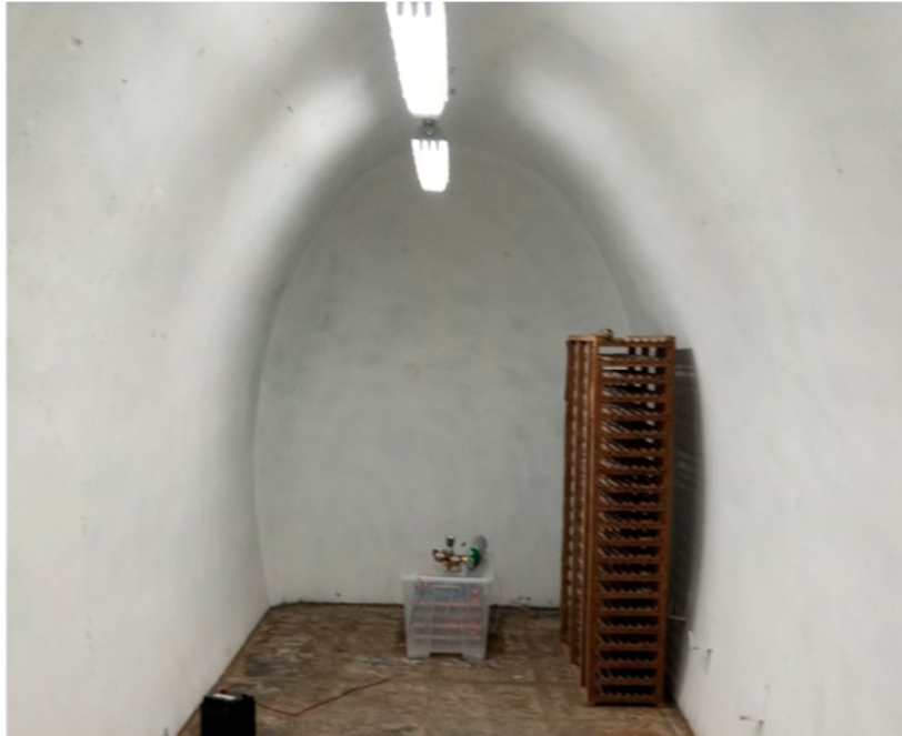
図6 地下20mにある観測坑道に設置された受信機（中央プラスチックボックス内）。
