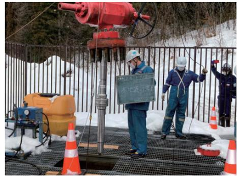
図3 高温対応光センサーシステムの地震計の大深度観測井への設置作業風景
