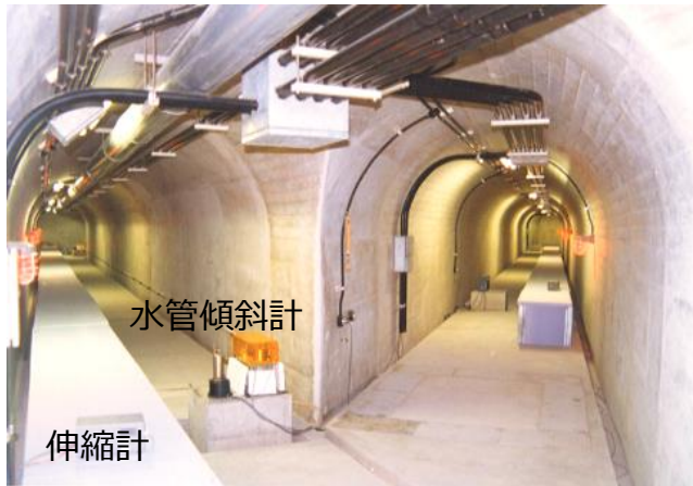
ハルタ山観測坑道内部
