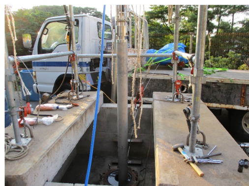
図48 (a)ハルタ山観測井の位置図、(b)改修機器設置時の写真。
