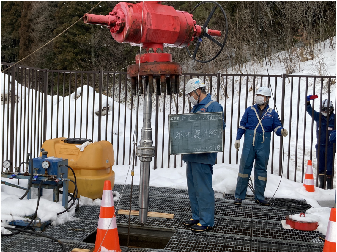
写真1 高温対応光センサの大深度観測井への設置作業風景
