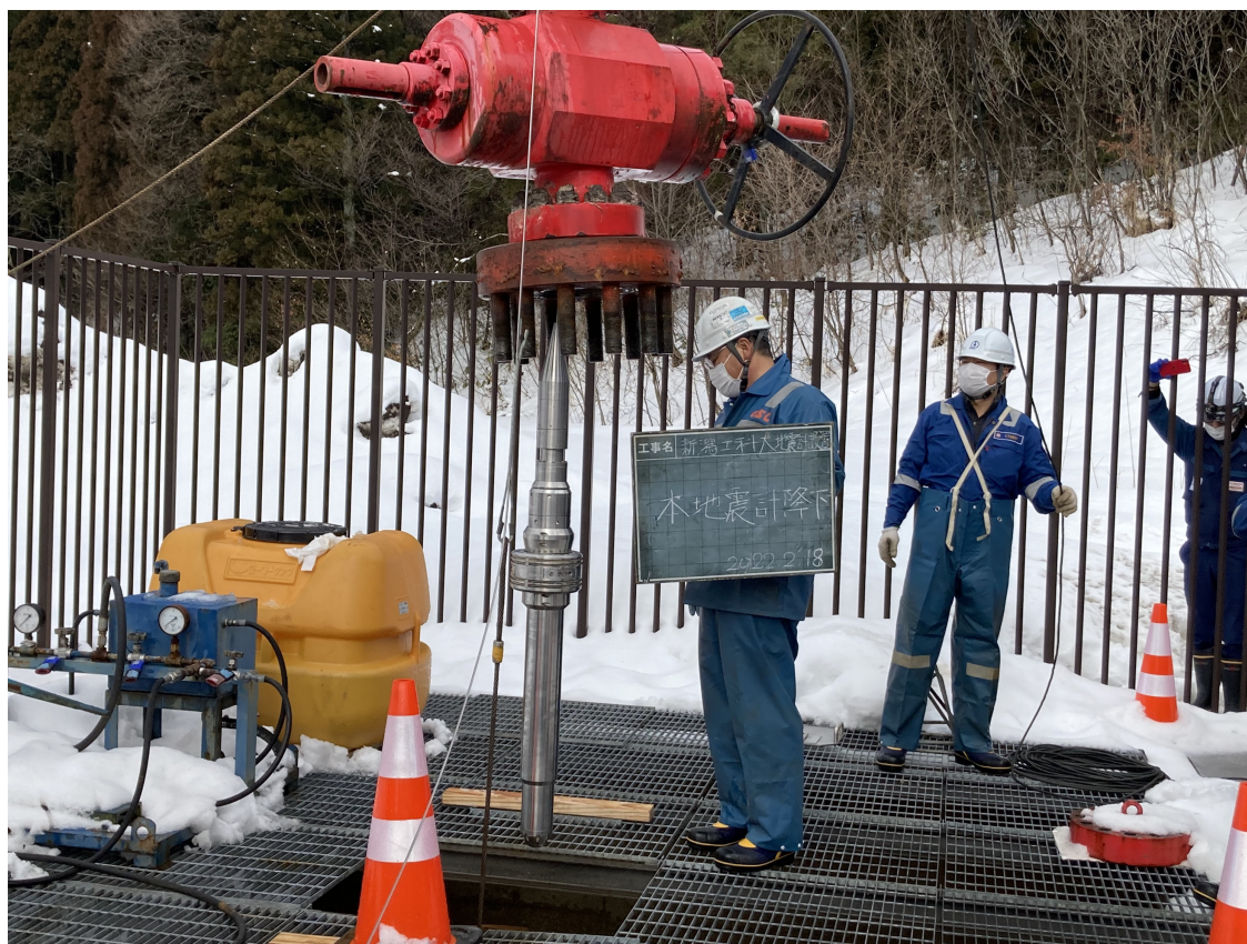
高温対応光センサの光センサの大深度観測井への設置作業風景
