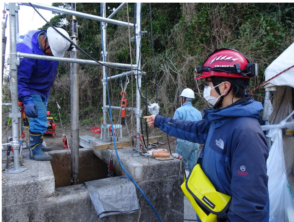
図 67 埋設型地震計・傾斜計の設置作業状況。
