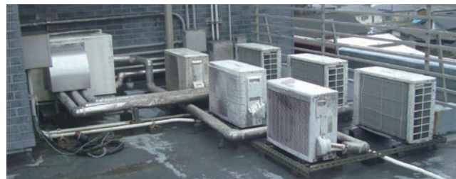
写真2 2016年阿蘇山噴火によるクーラー室外機付近の降灰状況
