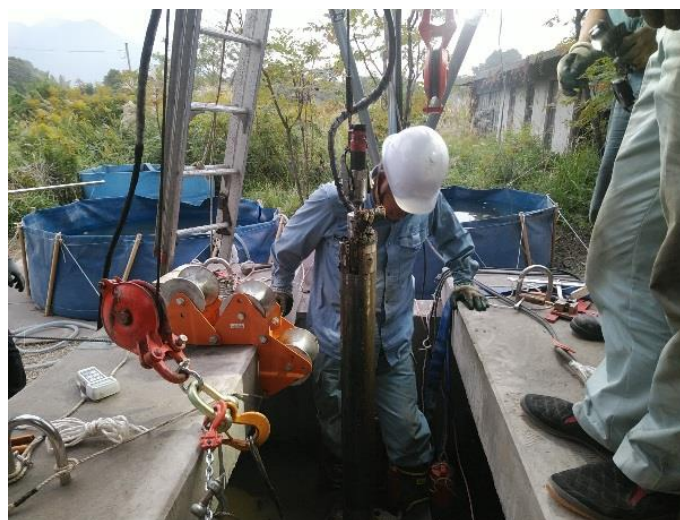
新島観測井の地震計、傾斜計の改修作業
