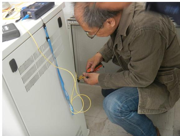
写真 4 光ケーブル空き芯線の通信テスト
