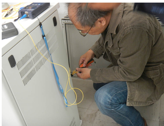
写真 4 光ケーブル空き芯線の通信テスト
