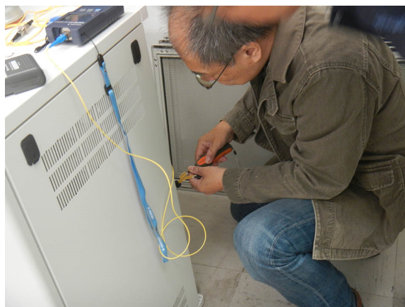
写真 6 光ケーブル空き芯線の通信テスト
