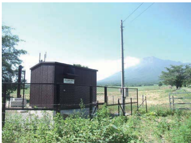
写真1 岩手山の火山観測施設
