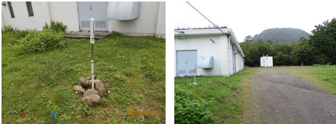
写真 4 GPS アンテナ設置
