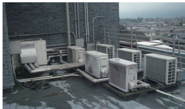
写真2：2016 年阿蘇山噴火によるクーラー室外機付近の降灰状況
