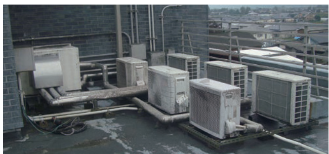
写真2 2016年阿蘇山噴火によるクーラー室外機付近の降灰状況
