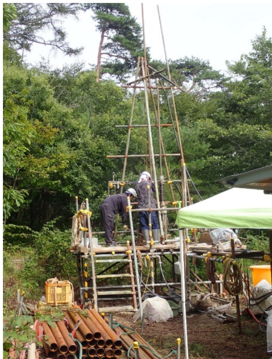
図 5 2 万山望北西ボーリングの掘削風景。
