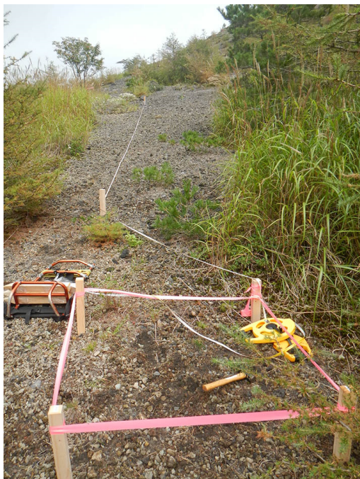
写真 3 A 点予定地．遠景は B 点予定地．
